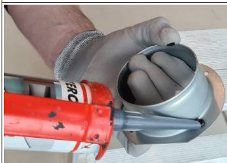
III. : 24: Réaliser l'étanchéité de la tubulure d'air primaire
