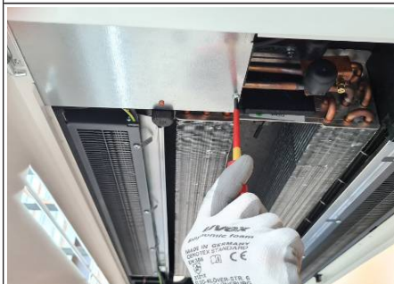
III. : 20: Ouvrir le boîtier de raccord électrique
