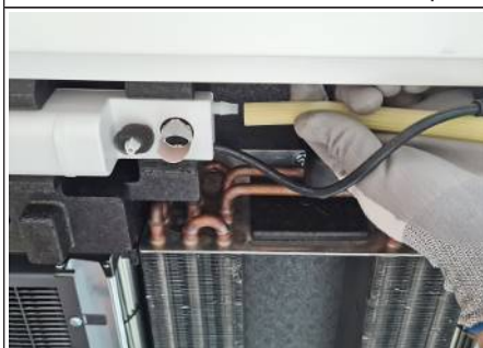
III. : 21: Fixer le flexible de condensat sur la pompe de condensat
