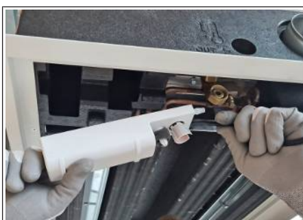
III. : 44: Démontez la pompe de condensat
