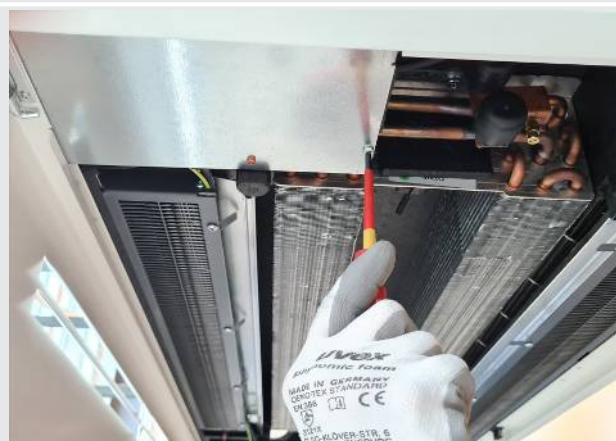
Ouvrir le caisson de raccordement électrique avec un tournevis cruciforme et retirer le couvercle du boîtier de raccordement électrique.
