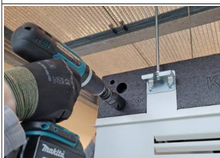
Ill. : 16: Ouvrir les trous de raccordement
